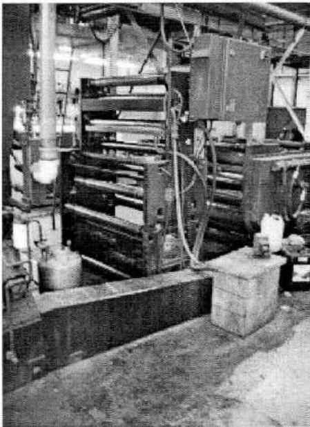
57- Unidade de aplicação de silicone-bomba
