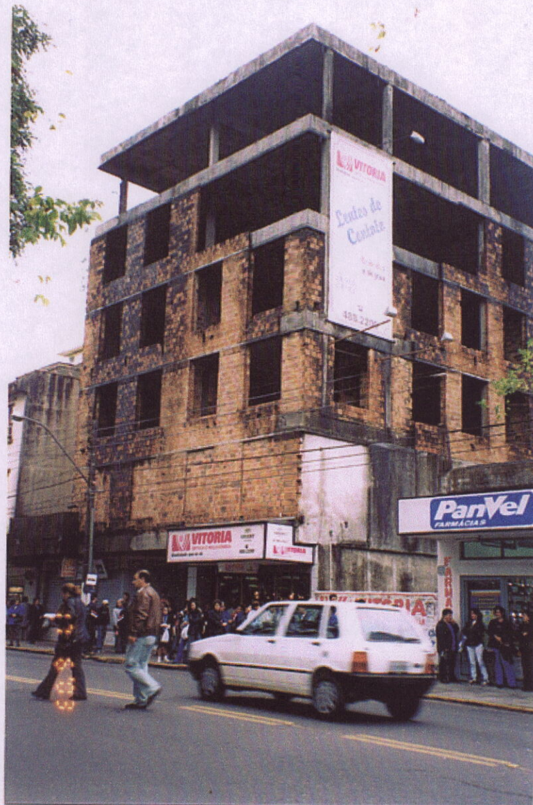
FOTO 01 - VISTA DA FACHADA
