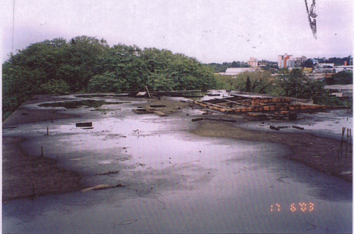
FOTO 04 – VISTA DA LAJE DO 7º PAVIMENTO
