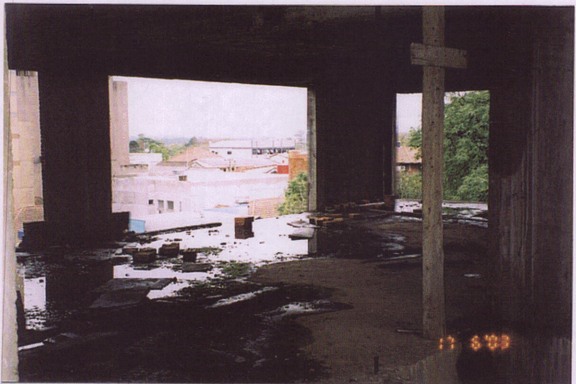
FOTO 05 – VISTA INTERNA DO 6º.PAVIMENTO
