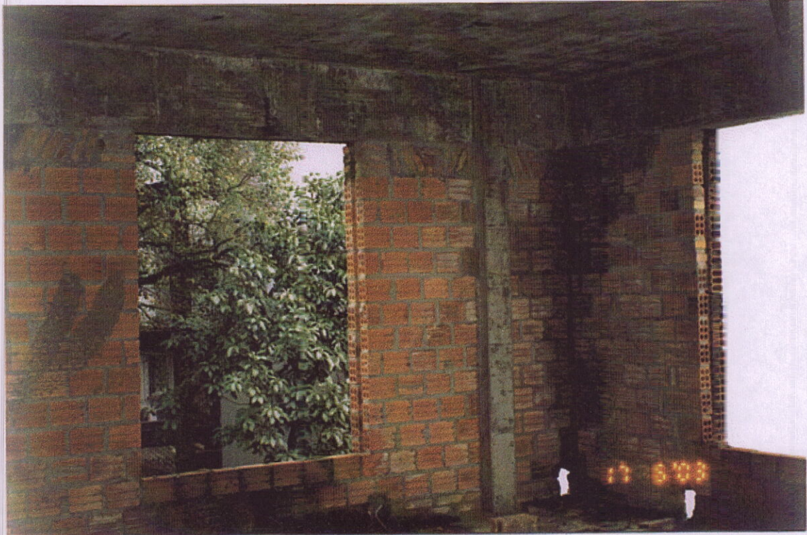
FOTO 06 – VISTA INTERNA DO CONJUNTO
