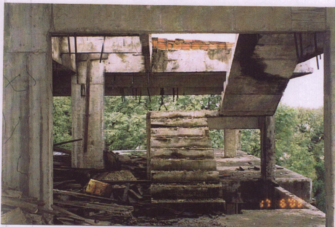
Rua Costa, 368 Barro Preto, Belo Horizonte, Minas Gerais, Brasil FOTO 09 - VISTA INTERNA DA CIRCULAÇÃO VERTICAL (51) 3231.1599 E-mail: crisazevedo@cpovo.net
