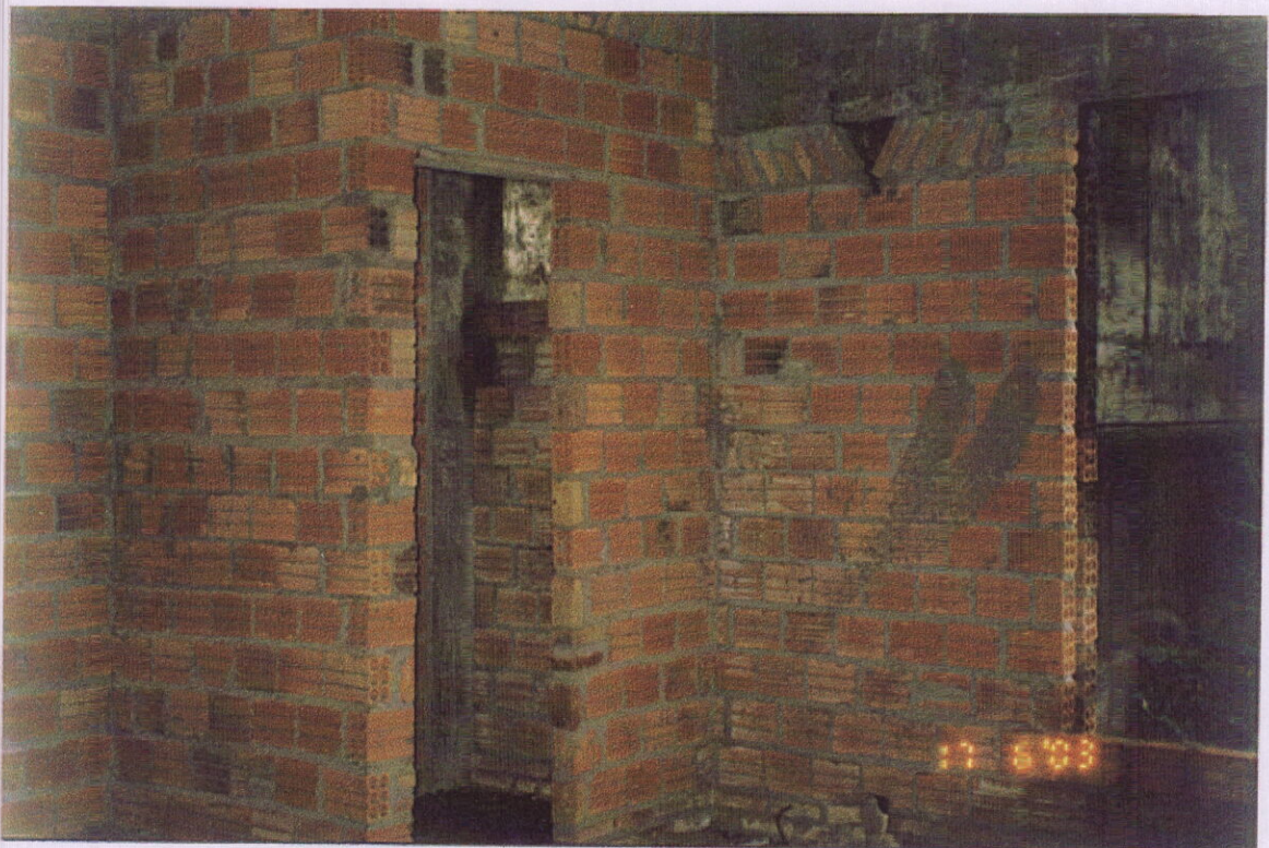
FOTO 07 – VISTA INTERNA DO SANITÁRIO
