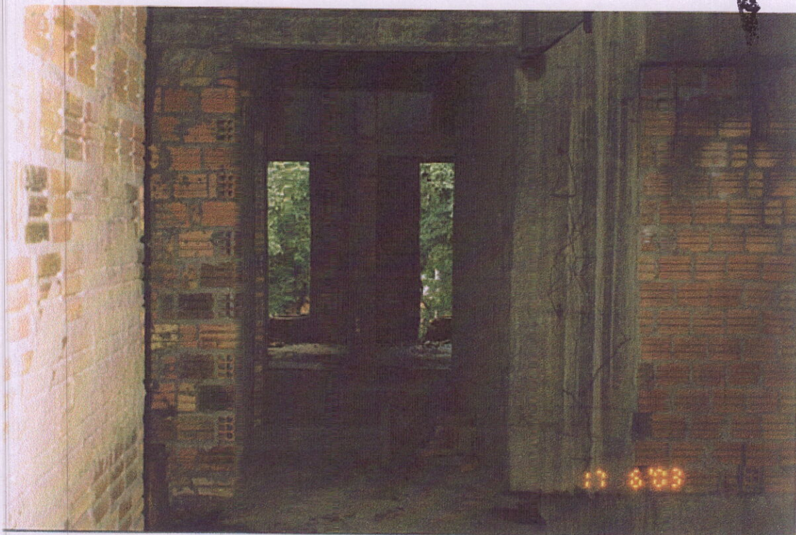
FOTO 08 - VISTA INTERNA DA CIRCULAÇÃO
