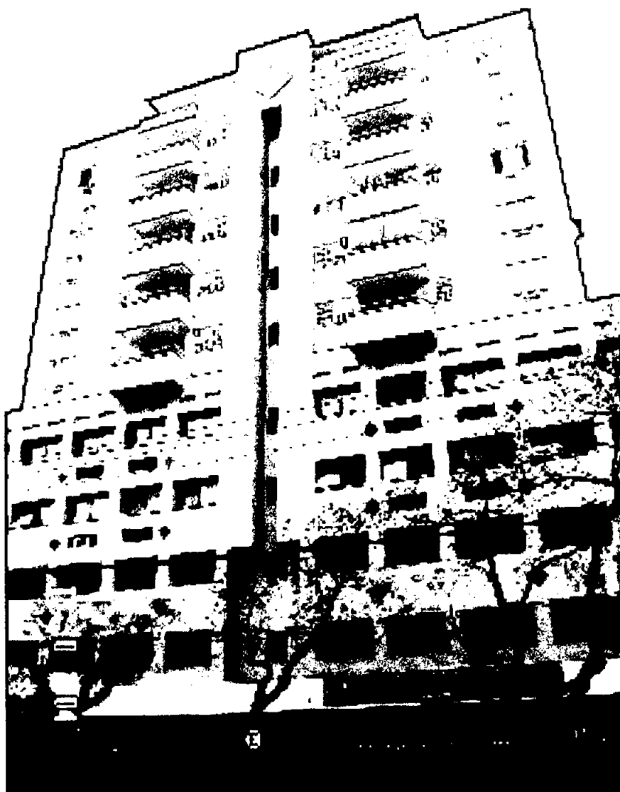
REGISTRO FOTOGRÁFICO DA VISTORIA Fachada do Prédio – Rua Doutor Timóteo
